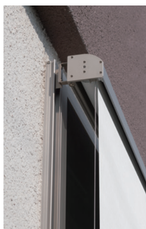
サッシ取付け時 上部アップ
