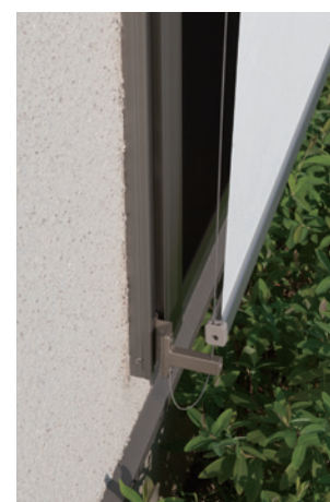
サッシ取付け時 下部アップ
